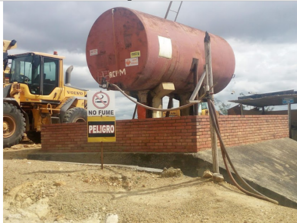
Foto No. 03. Detalle tanque de almacenamiento combustible (ACPM) vehículos
