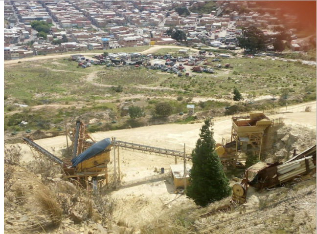
Foto No. 02. Detalle ubicación equipo "Trituradora"
